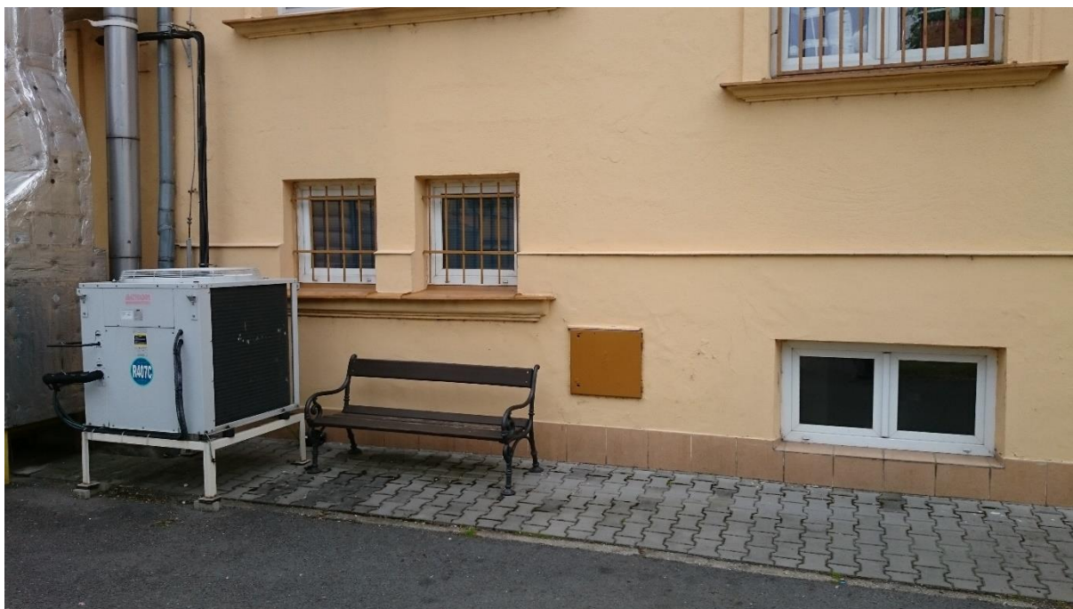
Obrázek 3 Pohled do dvora (Předpokládané umístění akumulací)
