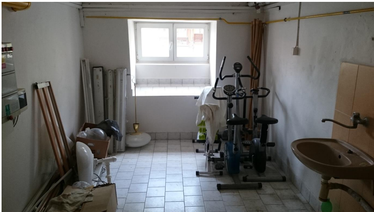
Obrázek 2 Místnost před kotelnou – předpokládané umístění KGJ)
